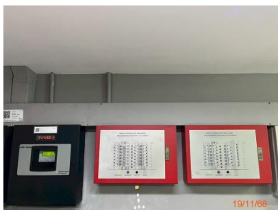
แผงควบคุมแจ้งเหตุเพลิงไหม้
